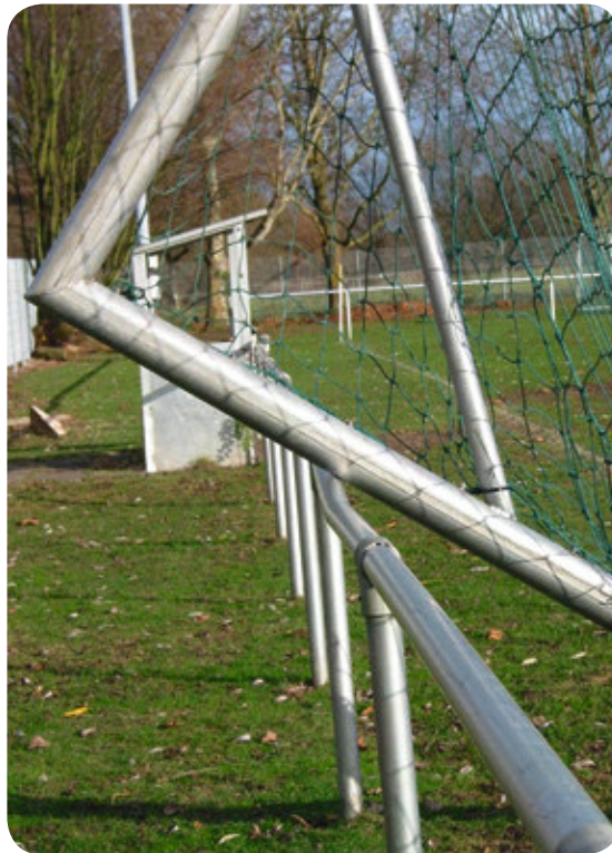
Abb. 135: Beschädigung der Barriere durch unsachgemäßen Transport des Tors
